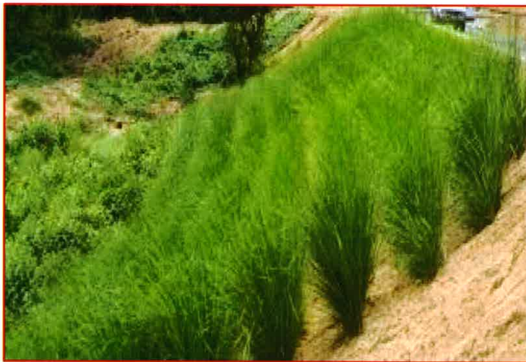
Ejemplo de aplicación de Vetiver
