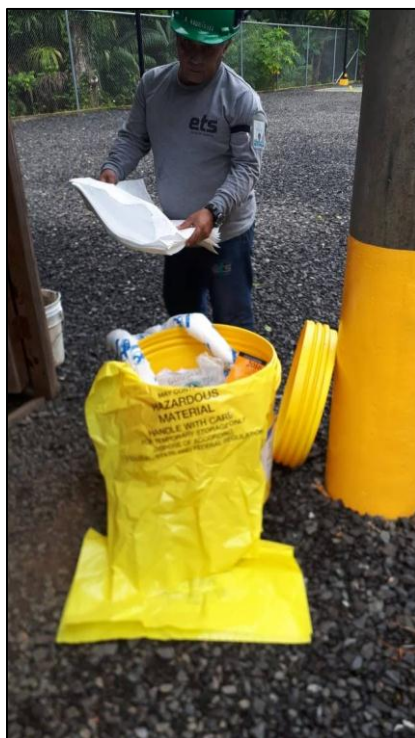
Imagen N°3. Se evidencia de que se mantiene en el sitio, el kit para la contención de los derrames de productos oleosos, para evitar la contaminación del medio por estos productos.
