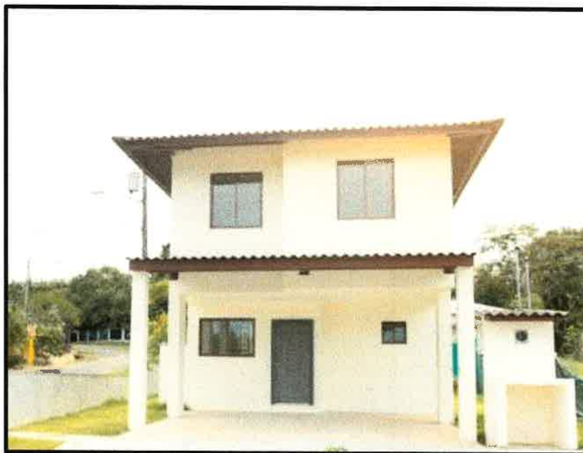
Figura 3. Primera vivienda de dos niveles construida en el polígono de proyecto
