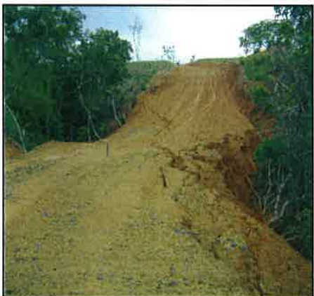
MOVIMIENTO DE TIERRA PARA INFRAESTRUCTURA VIAL. AGRIETAMIENTOS Y OBSTRUCCIÓN.
