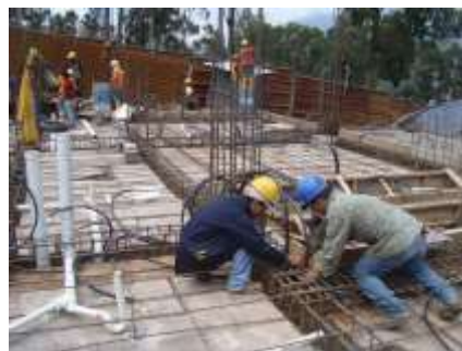
Imagen 5. Instalación de sistemas de tubería.
