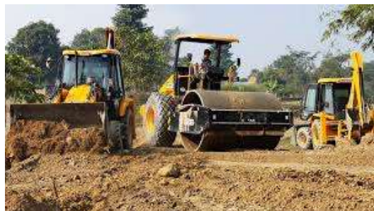
Imagen 12. Relleno y nivelación de terreno.
