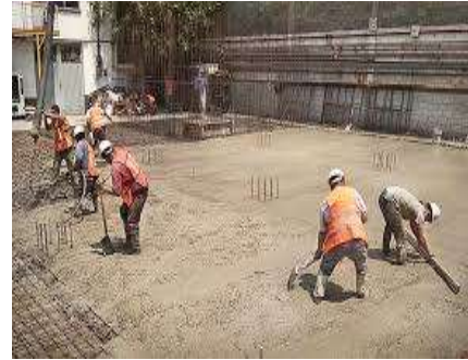
Imagen 7. Vaciado de concreto.
