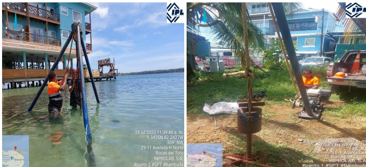
Figura 5.3.2. Sondeos realizados en el área del proyecto para pruebas de capacidad de soporte (SPT): Área de fondo marino (A) donde se nota la presencia superficial de arena en el área sobre fondo de mar a construir y solicitada en concesión al Estado, en tierra firme (B). © E. Aparicio. Julio, 2023.
