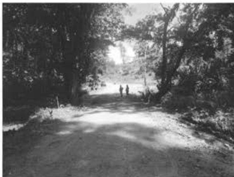
Figura 2. Se puede apreciar el ambiente físico presente en el puente de Quebrada Cacao. Coordenada: WGS-84 17 p_ 345483.00 m E_ 1022215.00 m N.
