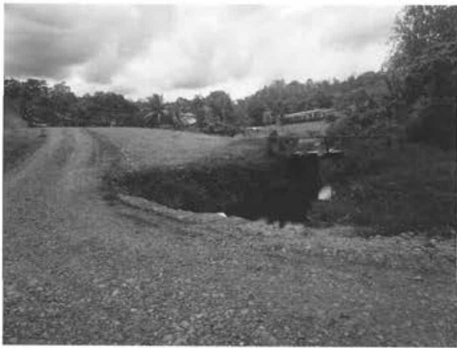
Figura 7. Se aprecia alcantarilla, rellena de tosca, la cual es utilizada como vía de acceso por los moradores de la comunidad de Quebrada Banano 2. Coordenada: WGS-84 17 p_ 340567.12 m E_ 1033090.46 m N.
