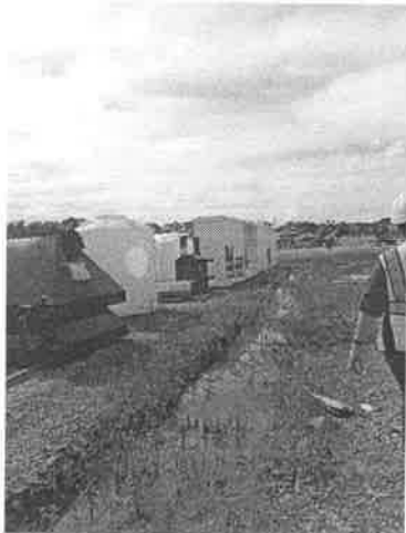
Figura No.7: Se muestra en la imagen fotográfica, un canal pluvial dentro del polígono, para el desagüe de las aguas pluviales existente en la zona, producidas propias de las precipitaciones.
