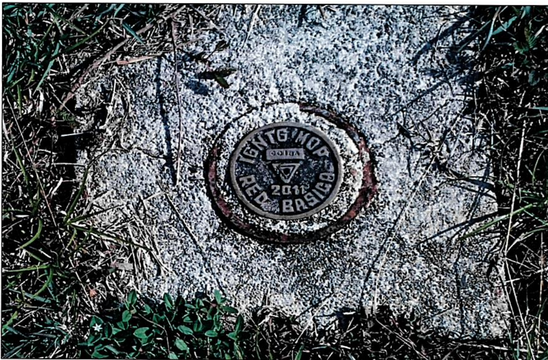
Imagen No3. Estación de Control Geodésico Isla de Coiba (COIB) , perteneciente a la Red Básica Nacional.
