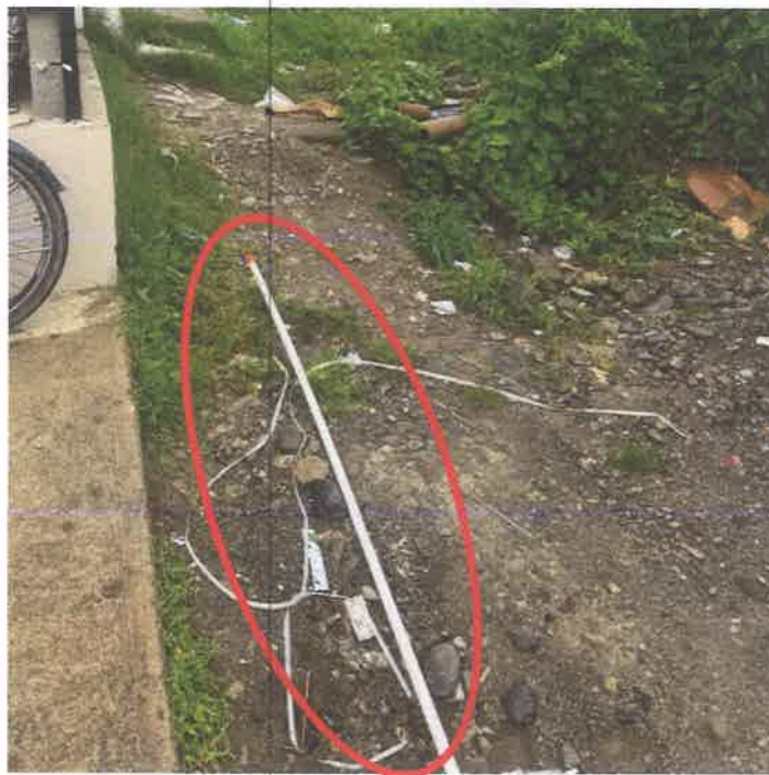
Foto N° 1 Instalación de conexión de agua potable.
