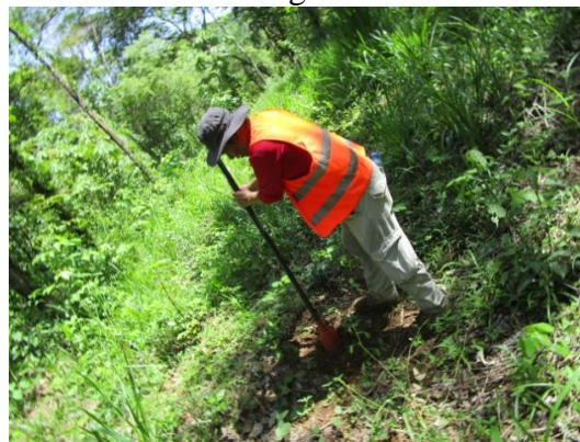
Foto 12. Aplicación de sondeo.
