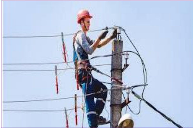
Imagen 4.20 Tendido de conductores
