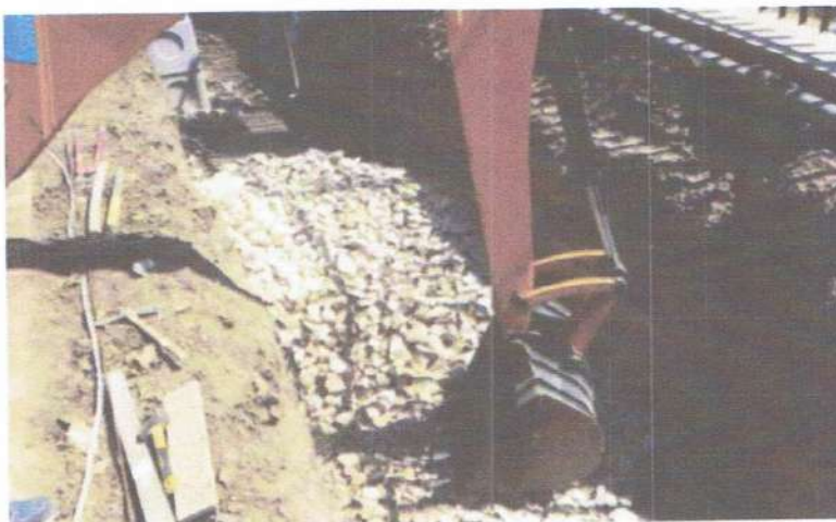
Detalle de la excavación de la zanja y colocación de la cama de piedras.
