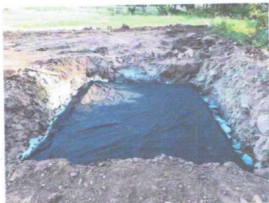
3 Colocacion de Geotextil (Opcional)
