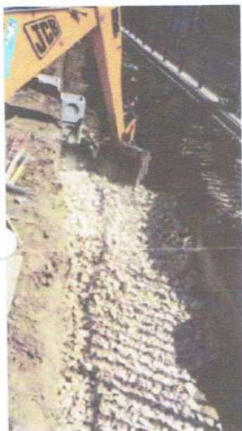
Detalle de la excavación de la zanja y colocación de la cama de piedras.
