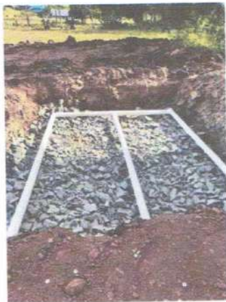
1 Colocación de la cama de piedra Tamaño 3- 4" tubería
